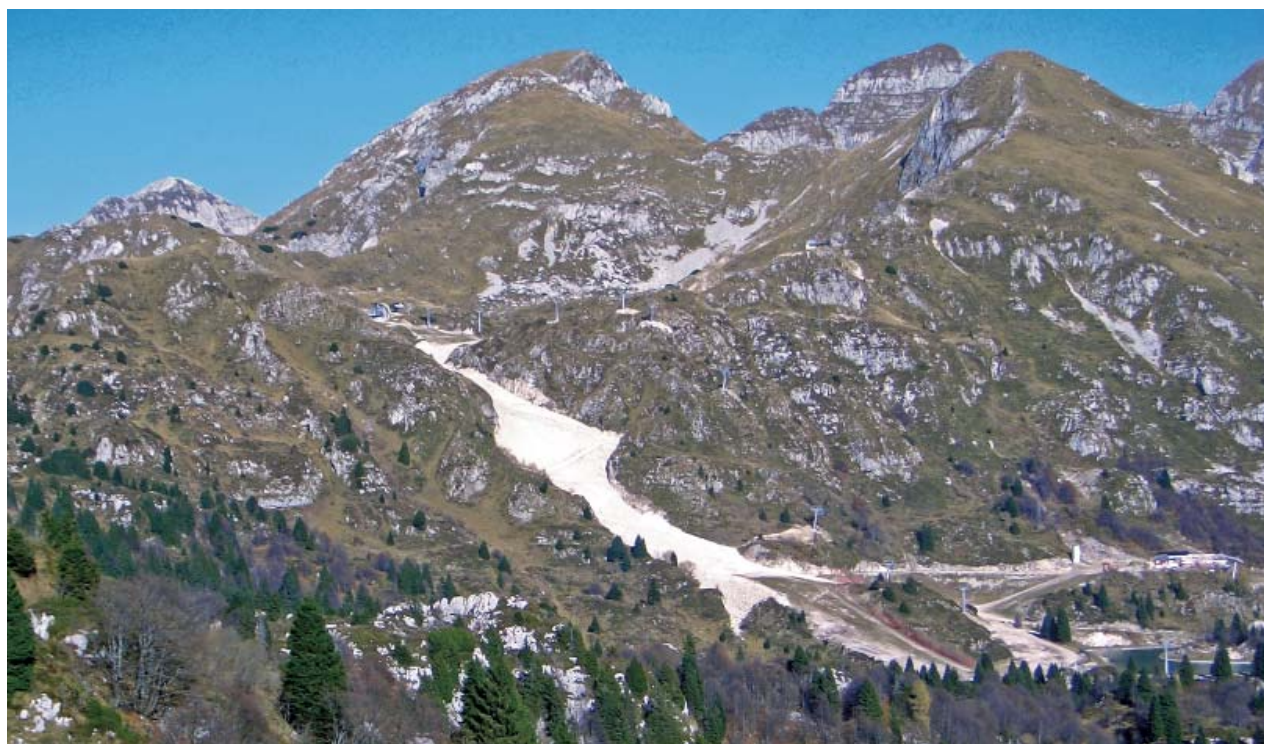
Lavori di ampliamento della parte alta della Pista Nazionale
